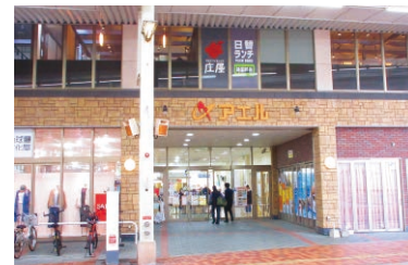
撤退したスーパーの跡地に整備した「アエルいさはや」
