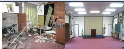
商店会館ホールの復旧前（左）と復旧後
