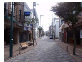
街路施設復旧事業完了後のことぶき町通り
